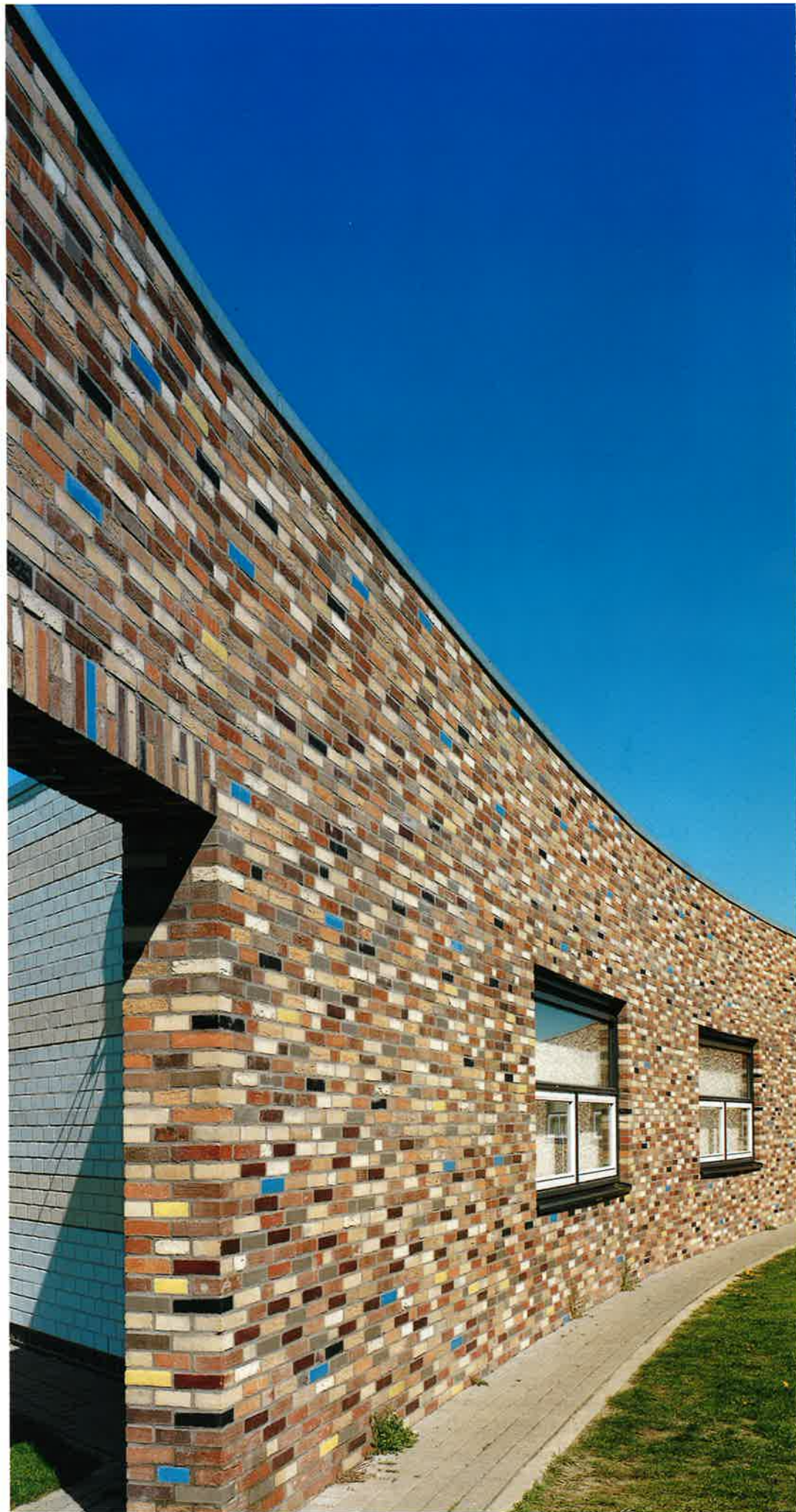
Wijkcentrum en kinderdagverblijf Purmerend-Zuid, door Inbo Architecten/Derk-Jan Huisman (foto Luuk Kramer)
